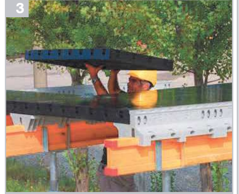
3 GEOPANEL® 120 panelini yerleştirin
