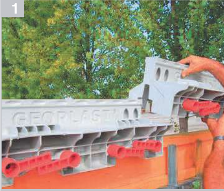
1 Önceden monte edilmiş Y kirişleri ve kamaları yerleştirin
